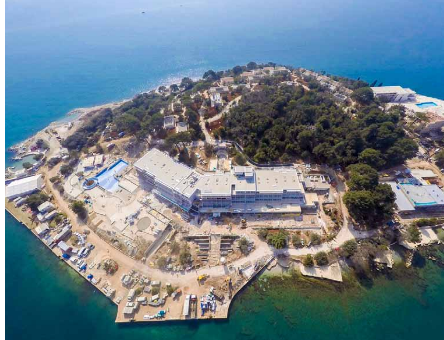
Valamar Isabella Island Resort tijekom građevinskih radova
